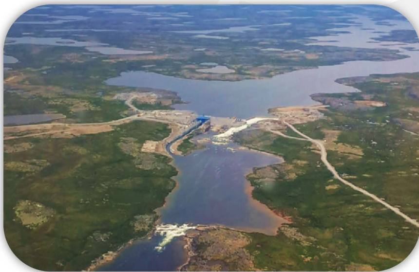
CENTRALE HYDROÉLECTRIQUE D'INUKJUAQ VUE DU CIEL
